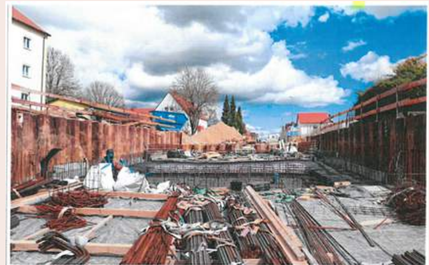
Das letzte Stück der Grundwasserwanne in der Wemdinger Unterführung wird in der kommenden Woche betoniert. Anschließend sind alle geplanten 13 Bauabschnitte abgeschlossen. Der noch benötigte Bewehrungsstahl für die Seiten- und Außenwände liegt im Moment tonnenweise vor dem Bauwerk. Foto: ©: Leonie Jungmann
