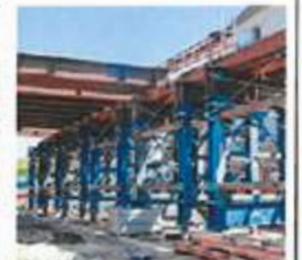
Auf dieser Konstruktion wurden die Bauteile an die richtige Stelle geschoben.
