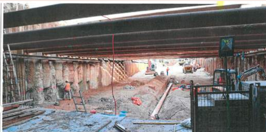
An der Baustelle am neuen Wemdingener Tunnel gehen die Arbeiten im östlichen Bereich des Bauwerks weiter. Nach der Abtragung des Bodens ist jetzt deutlich zu sehen, wie die Entwässerungsrohre unterhalb der Grundwasserwanne verlaufen werden. Foto: Leonie Junghanns
