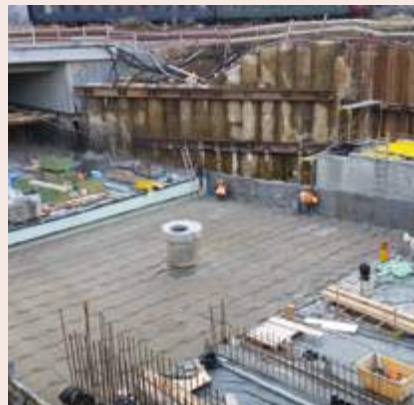
Das letzte Stück der Grundwasserwanne in der Wemdinger Unterführung wird in der kommenden Woche betoniert. Anschließend sind alle geplanten 13 Bauabschnitte abgeschlossen. Der noch benötigte Bewehrungsstahl für die Seiten- und Außenwände liegt im Moment tonnenweise vor dem Bauwerk. Foto: ©: Leonie Jungmann
